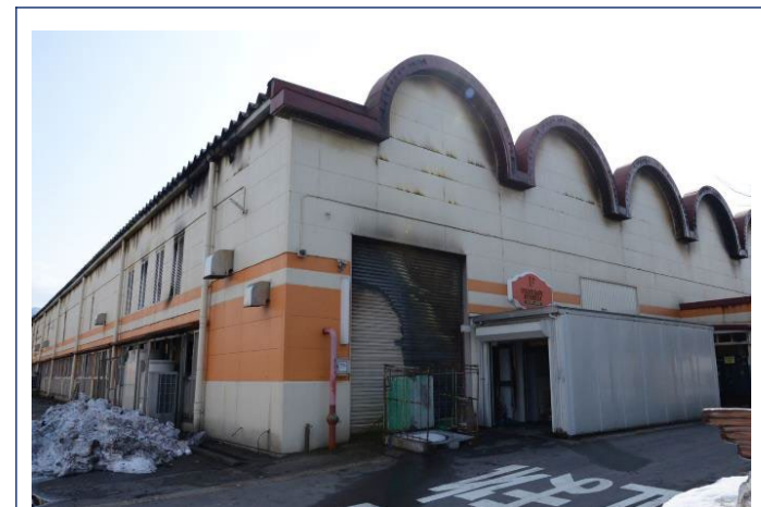
建物外観（北側西寄り）
