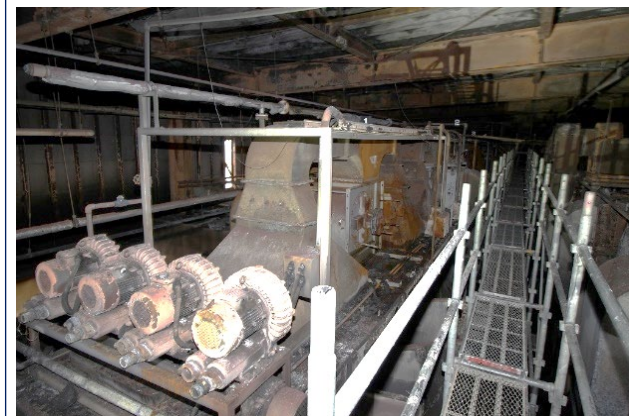
図2：3号機上段乾燥機 西側天面
