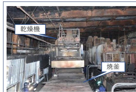
図9：乾燥機と焼き釜の設置状況
